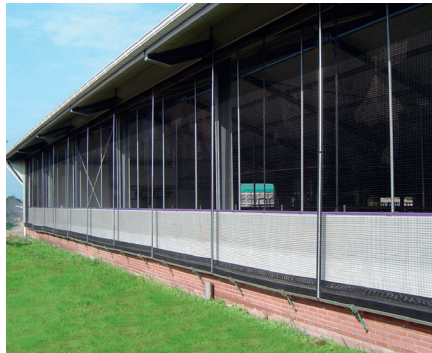
Büyükbaş hayvan barınaklarının yan taraftan havalandırılması için örtü tutucu
