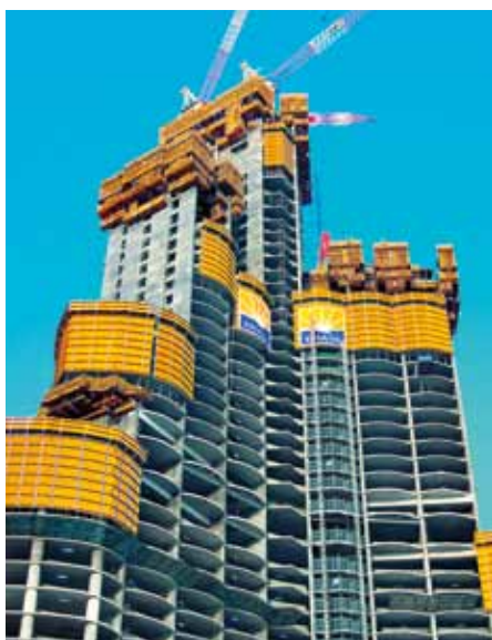
Vid byggnation värdesätts skarpkantiga radiutföranden högt. Detta för att betong inte ska flyta ut och kostsamma efterslipningar undvikas, som här vid bygget av Burj Dubai.
