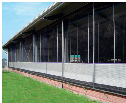
Sujeción de telas para la ventilación de establos
