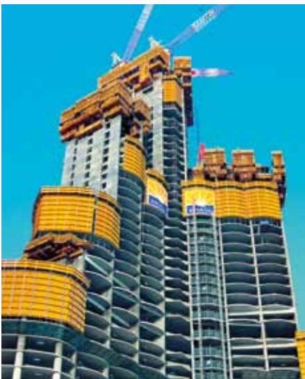
Bei Schalungen wird auf eine scharfkantige Ausführung der Radian Wert gelegt. Dadurch kann kein Beton entweichen und aufwändiges Nachschleifen entfällt, wie hier beim Bau des Burj Dubai.
